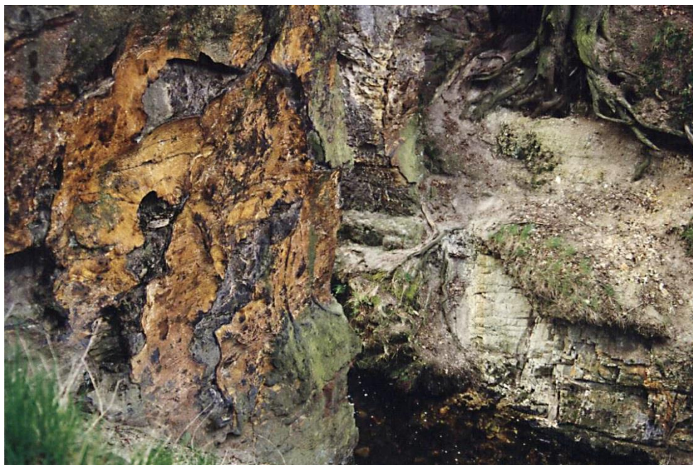
Obr. 29. Pohled přes rozloženou a erodovanou žílu tefrifonolitu na její kontakt s pískovcem se zprohýbanými laminami železitých hmot. Hráz Břehyňského rybníka v Břehyni.
