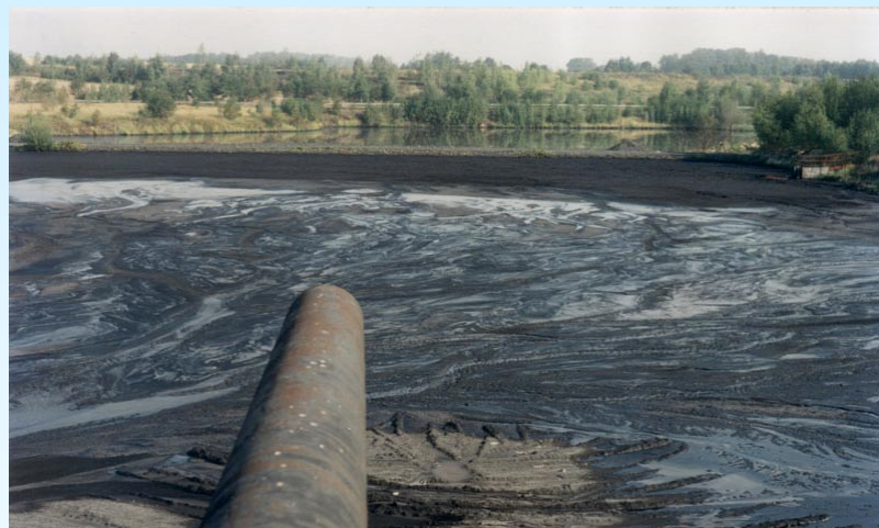
Část antropogenní krajiny na Ostravsku a Karvinsku. Odkaliště u helných kalů, popílků a flotačních odpadů v bezodtoké kotlině u Stonavy. Foto F.Reichmann.
